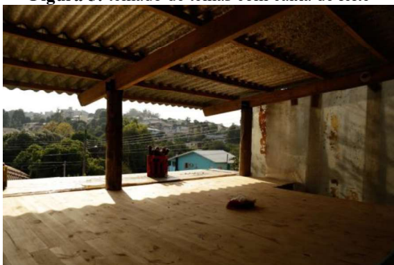
Figura 5: telhado de telhas com caixa de leite
