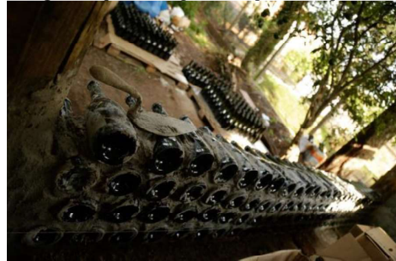
Figura 2: parede de garrafas e pilares de postes
